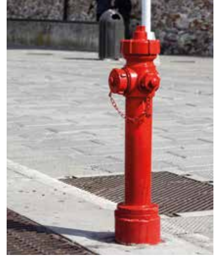
Hidrانت: Bina dışında hortum bağlanarak müdahale etmek için bulundurulur.
