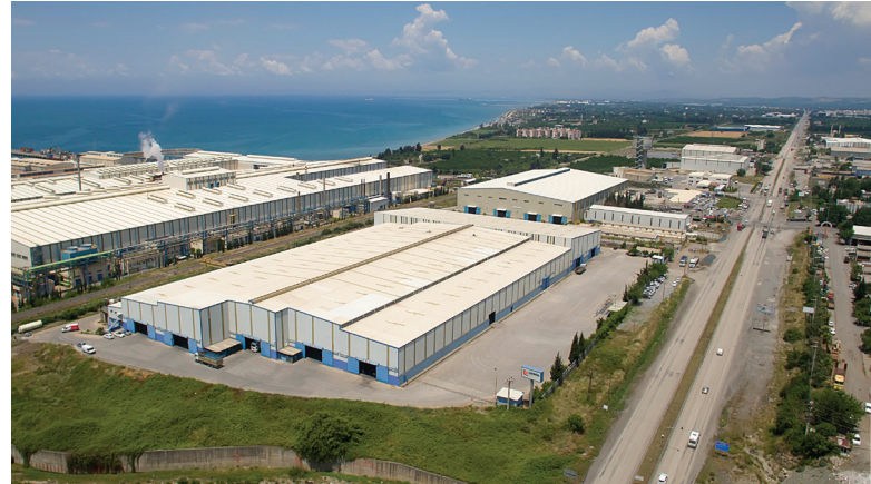
Çayırova Boru Fabrikası Dört Yol/Hatay
