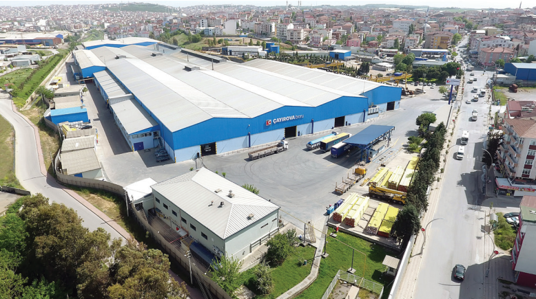
Çayırova Boru Fabrikası Darıca/Kocaeli
